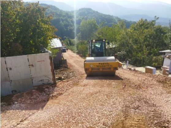
Gözede Mahallesi İmar Yolu Tesviye Çalışması
