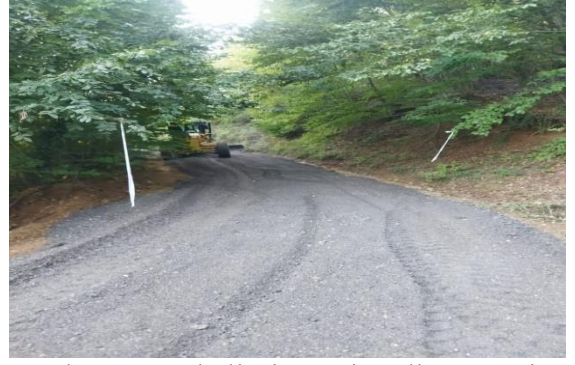
Kozluören Mahallesi Arazi Yolları Tesviye Çalışması
