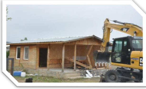
Gölçük Mahallesi Kaçak Yapı Yıkımı
