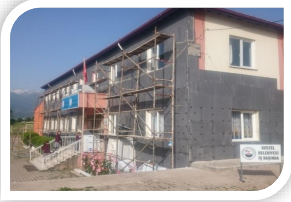
Ümitalan İlkokulu Dış Cephe Mantolama ve Boyanması
