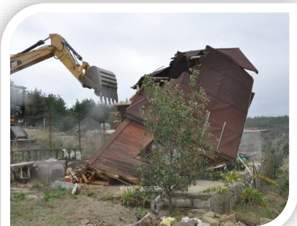
Kayacık Mah. Kaçak Yapımı Yıkımı
