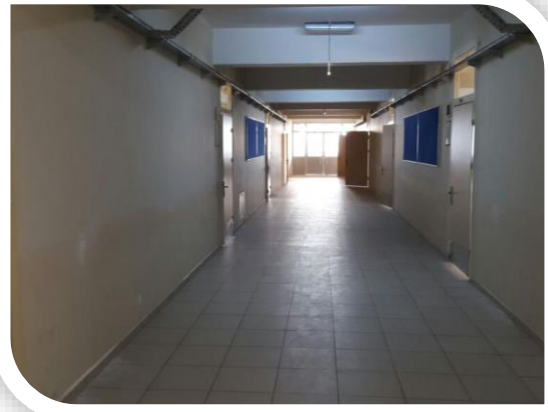
Hasan Aslanoba Anadolu Lisesi Sınıf ve Koridorlarının Boyanması İşİ
