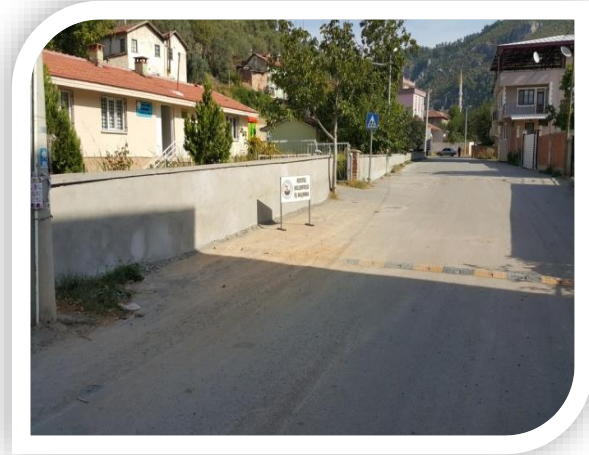
Narlıdere İlkokulu Bahçe Duvarı Yapılması
