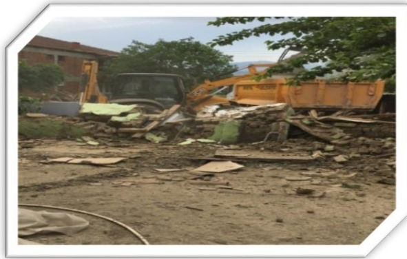
Dudaklı Mahallesi Tehlikeli Yapı Yıkımı
