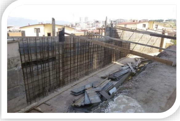
Vani Mehmet Mah. Çalışkan Sok. Perde Duvar Yapılması
