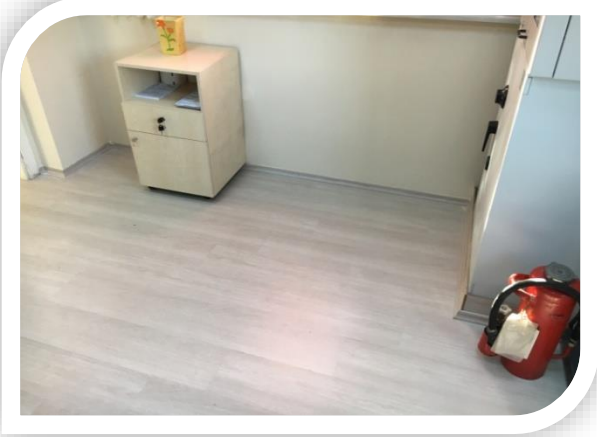
Yeni Mahalle Mahalle Konağı Laminat Parke Kaplaması İşİ
