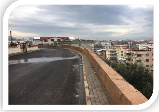
Vani Mehmet Mah. Çalışkan Sok. Perde Duvar Yapılması
