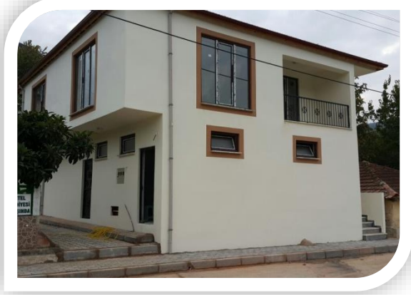
Seymen Cami Müştemilatı Yapımı
