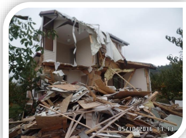
Gölcük Mahallesi Kaçak Yapı Yıkımı
