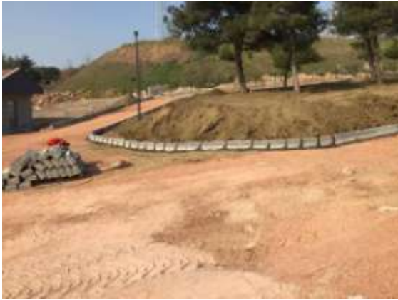
Hayvan Barınağı Çevre Düzenleme Çalışması
