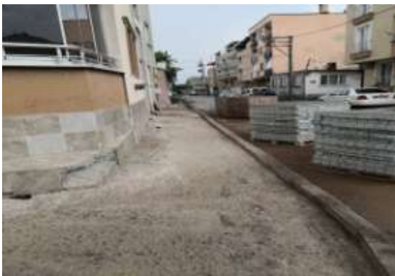
Çeşme Sokak Kaldırım Yenileme Çalışması
