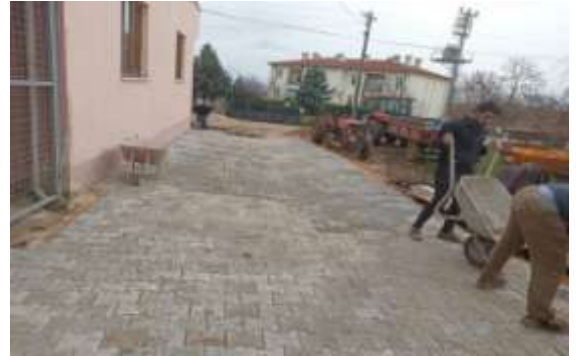
Ümitalan Mahallesi Parke Taşı İmalatı
