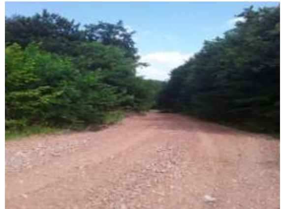
Sayfiye Mahallesi Arazi Yolu Tesviye Çalışması
