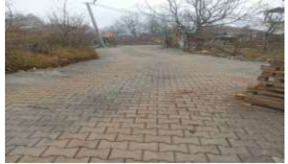
Osmaniye Mahallesi Parke Taşı İmalatı
