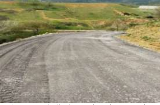
Erdoğan Mahallesi Arazi Yolu Düzenleme Çalışması
