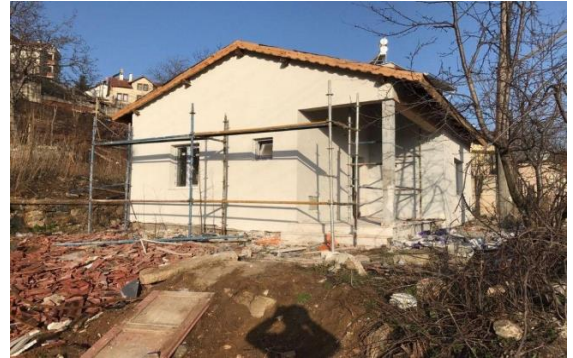
Saitabat Mahallesi Okul Binası Tadilatı
