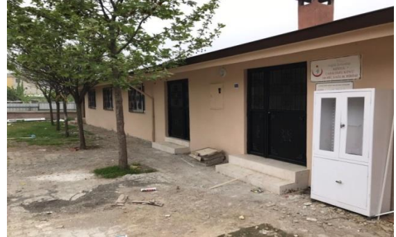
Çataltepe Mahallesi Sağlık Ocağı Tadilatı
