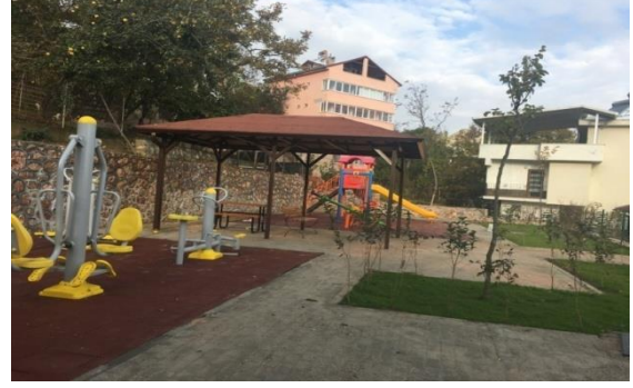
Saitabat Mahallesi Parkı Yapım Sonrası
