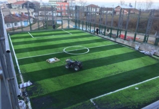
Şevketiye Mahallesi Halı Saha Yapımı
