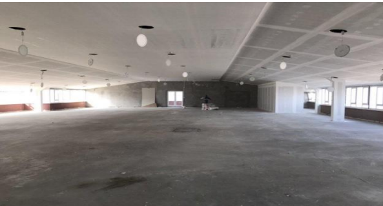
Anadolu İmam Hatip Lisesi Çatı Bakım Onarım ve Tadilat İşleri Öncesi
