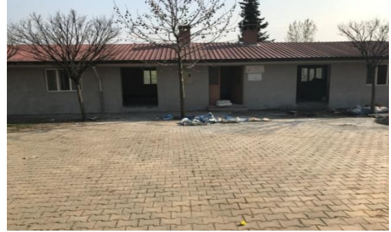
Çataltepe Mahallesi Eski Okul Tadilatı
