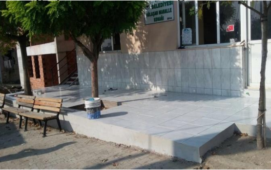
Ağlaşan Mahalle Konağı Tadilatı
