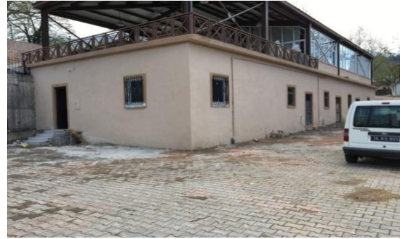
Babasultan Mahallesi Soyunma Odası Onarım Sonrası
