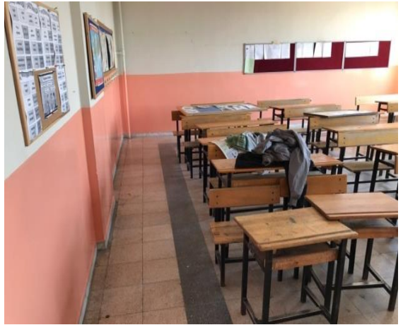
Gözede İlkokulu İç Cephe Boyası
