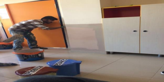
Toplu Konutlar İlkokulu İç Cephe Boyası
