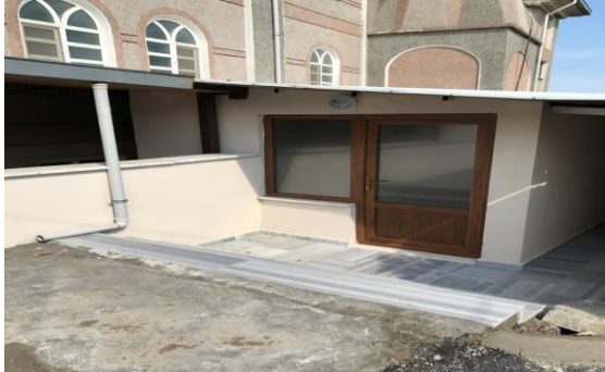
Saitabat Mahallesi WC Yapımı
