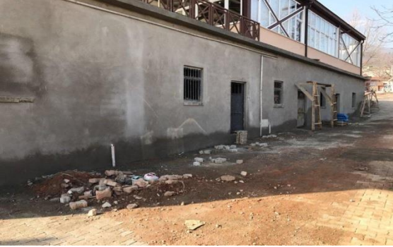
Babasultan Mahallesi Soyunma Odası Onarımı
