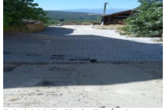
Gölcük Mahallesi Parke Taşı İmalatı
