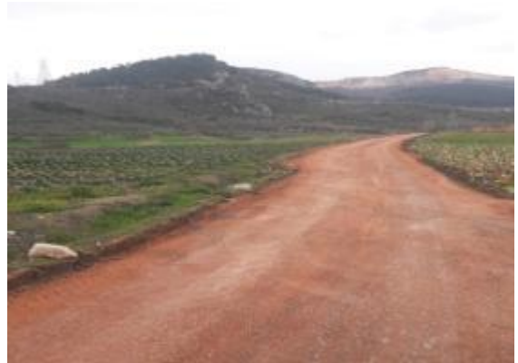
Dudaklı Mahallesi Arazi Yolu Düzenleme Çalışması
