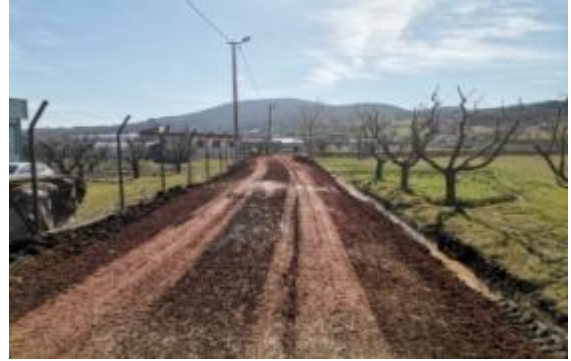
Erdoğan Mahallesi Arazi Yolu Tesviyesi
