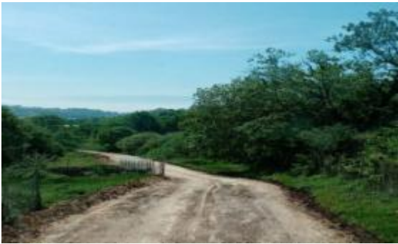
Ümitalan Mahallesi Yol Düzenleme Çalışmaları
