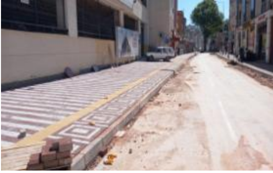
Cuma Caddesi Kaldırım Yenileme Çalışması
