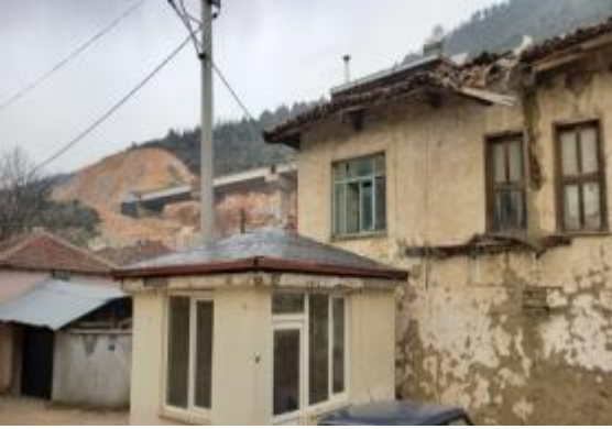
Dudaklı Mahallesi Berber Dükkanı Bakım Onarım Çalışması Yapılması
