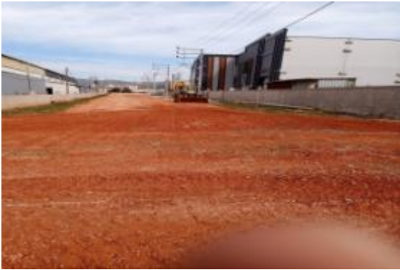
Turan Mahallesi Arazi Yolu Düzenleme Çalışması
