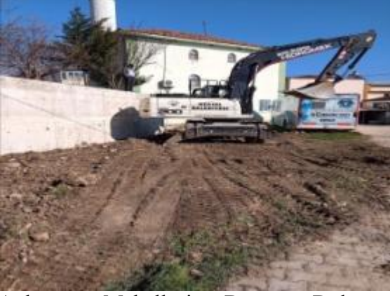
Ağlaşan Mahallesi Duvar Dolgusu Yapılması
