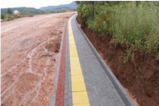
Mert Caddesi Kaldırım İmalatı Yapılması
