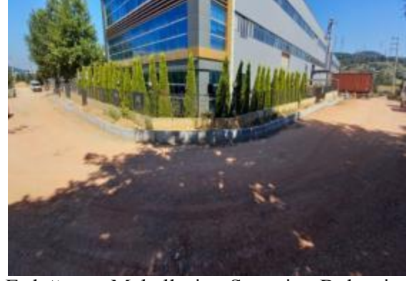
Erdoğan Mahallesi Sanayi Bölgesi Kaldırım Çalışması
