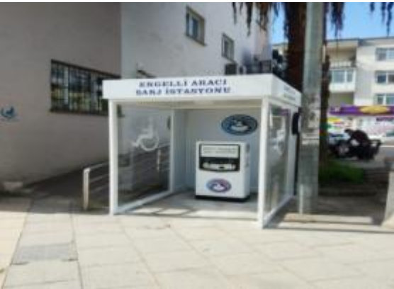
Kent Meydanı Engelli Şarj İstasyonu Yapımı
