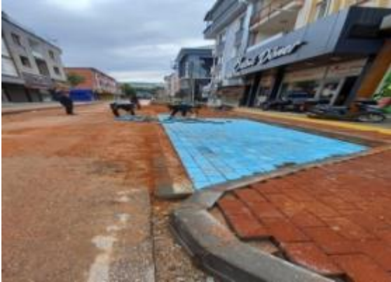
Ortaokul Caddesi Kaldırım Yenileme Çalışması
