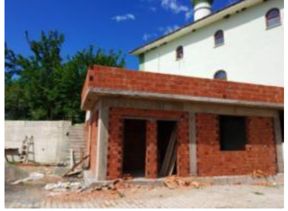
Ağlaşan Mahallesi Abdestlik ve Wc Yapılması
